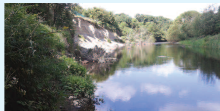
Oibreacha Cobhsaithe Fána ag WWTW Bhun Clóidí - Roimh Ré
