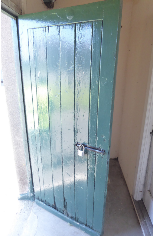
Fig. 50: Possible original timber door
